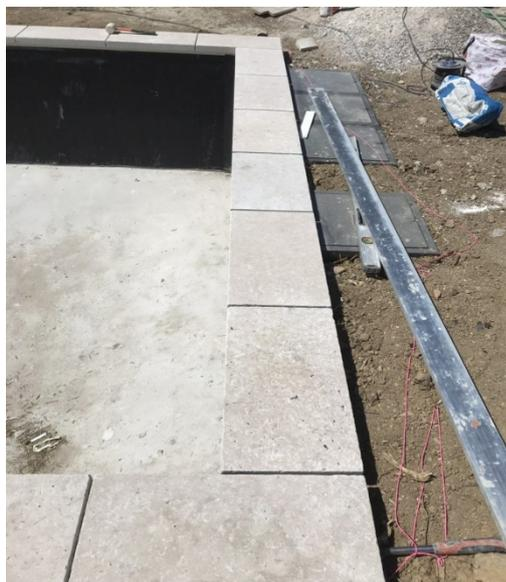
L'avantage avec le concept Magiline est que le procédé de construction permet de creuser le juste nécessaire, soit 15 cm tout autour du bassin.
